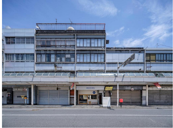
図2 活用事例(静岡県富士市)
