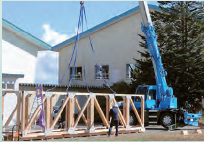
木製トラス構造による緊急架設橋の開発
