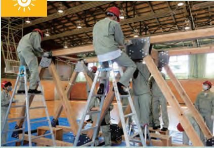
木製トラス構造による緊急架設橋の開発
